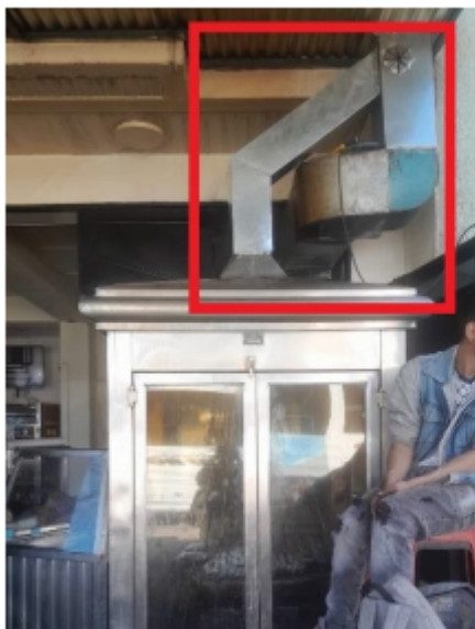
Fotografía 7. Conexión del horno tipo trompo al ducto de descarga
